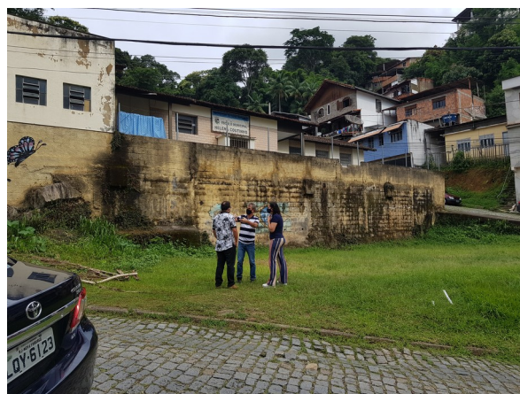
DESENTUPIR SAÍDAS DE ÁGUA PLUVIAL NO MURO
