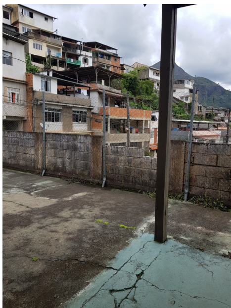
REFORMAR MURO E ACERTAR PISO DO PÁTIO
