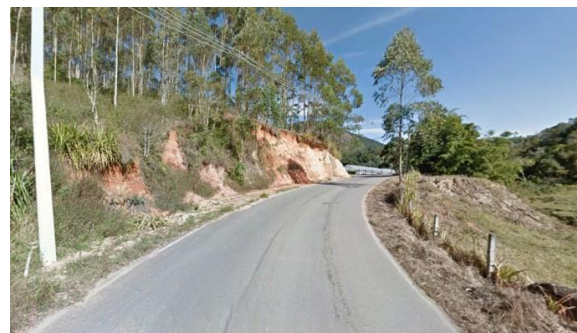
Fig.: 18 – Estrada para Vargem Alta: exemplo de Via Coletora de Nova Friburgo.
