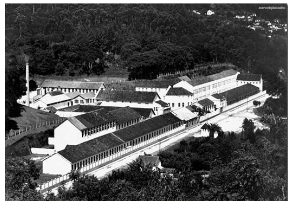
Fig.10 – Fábrica Filó S/A – fundada em 1925 Fonte: historiadefriburgo.blogspot.com.br
